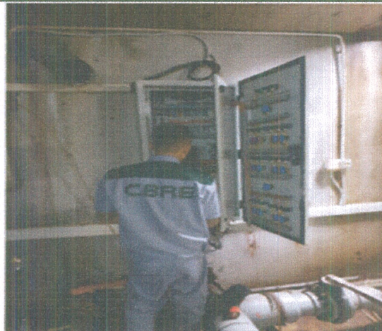
Kỹ Thuật kiểm tra bảo dưỡng hệ thống tủ điện, Busway
